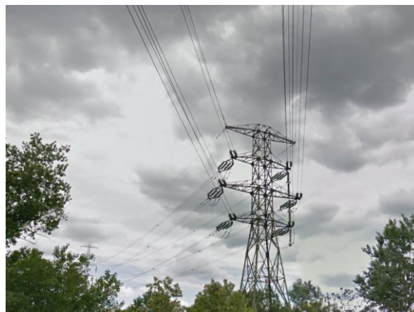
Albertfalva – Csepel 120 kV-os légvezetékes rendszer rácsos tartóoszlopon
