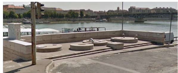
Bertalan Lajos utcai térszíni átemelőtelep forrás: maps.google.com
