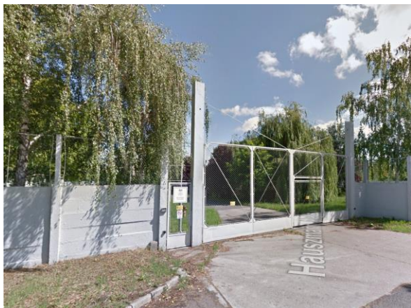
Kelenföld 120/10 kV-os alállomás
