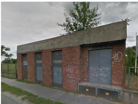
0248 sz. 10/0,4 kV-os épületben elhelyezett transzformátor a Budafoki úton
