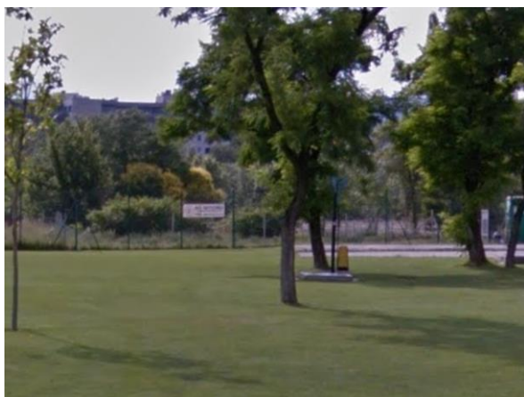
Földbe süllyesztett nagyközép/növelt kisnyomású gáznomásszabályzó a Kopaszi-gátnál
