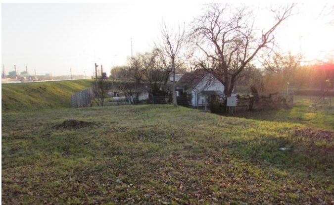
MOL termékvezeték budai fogadóépülete
